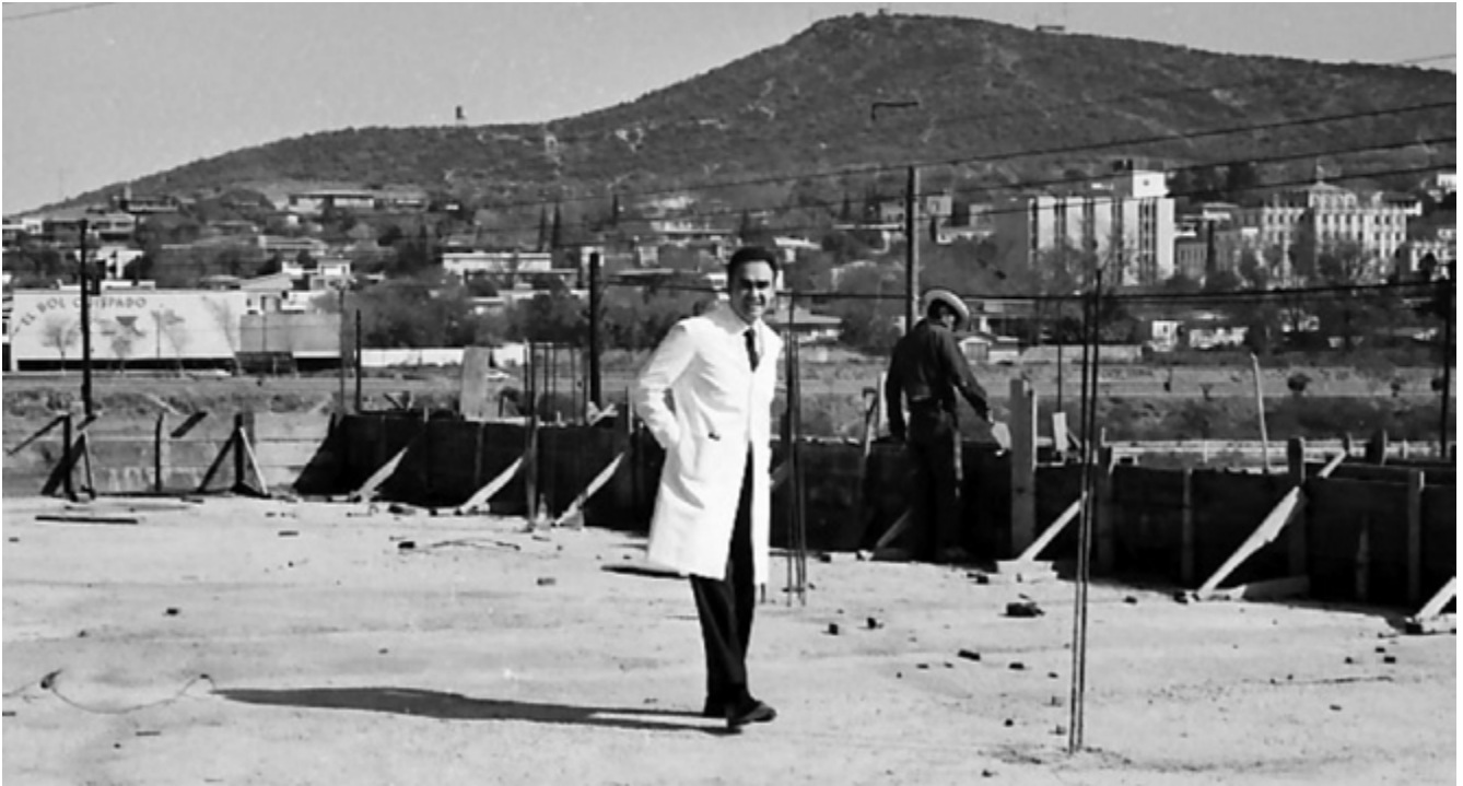
Dr. Francisco Alaníz Camino. Cimientos del edificio de consultorios para Médicos (Principios de los 70's).
