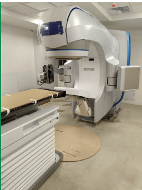
14 y 15: Fotografías de los nuevos equipos instalados.
