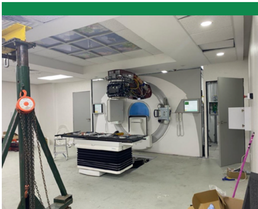
14 y 15: Fotografías de los nuevos equipos instalados.
