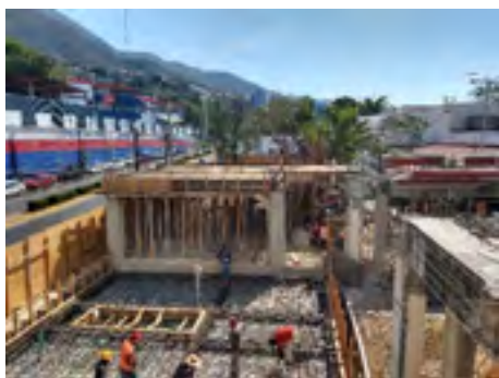
Construcción de búnkers y nuevas áreas asociadas al servicio de radioterapia. Julio de 2019.
